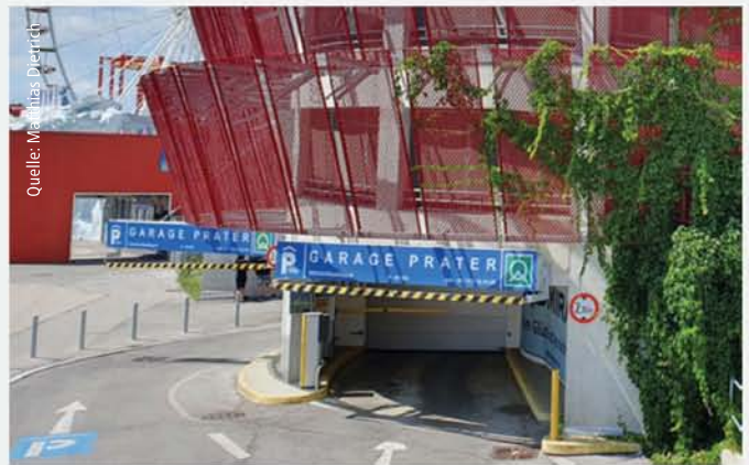
Laut Entwurf der neuen Muster-Garagenverordnung ist auch für offene Mittel- und Großgaragen min. ein feuerhemmendes, nichtbrennbares Tragwerk nachzuweisen.
